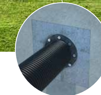
Hauseinführung – drückendes Wasser
